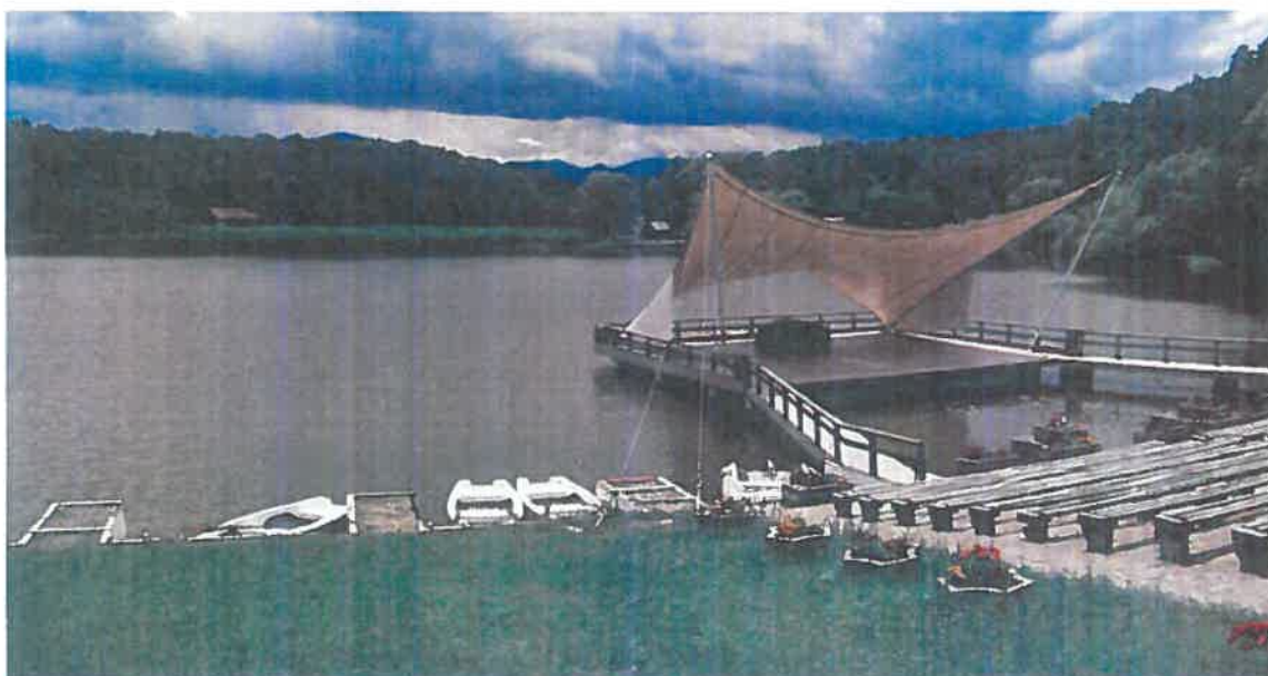
Fig.2 Scenă cu copertină dezafectată
