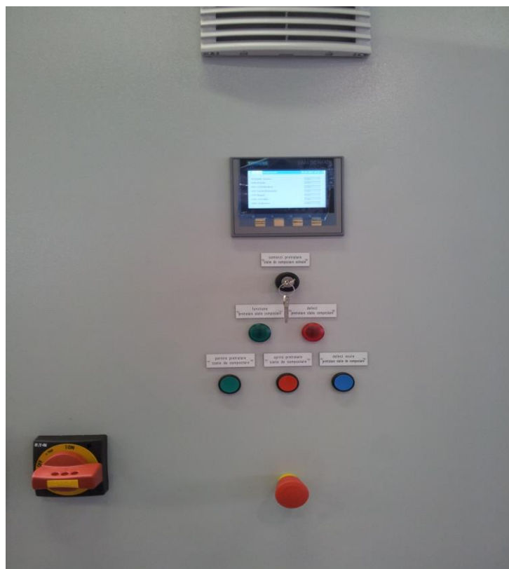
Figura 5-3: Butoane de comandă din panoul principal de control
