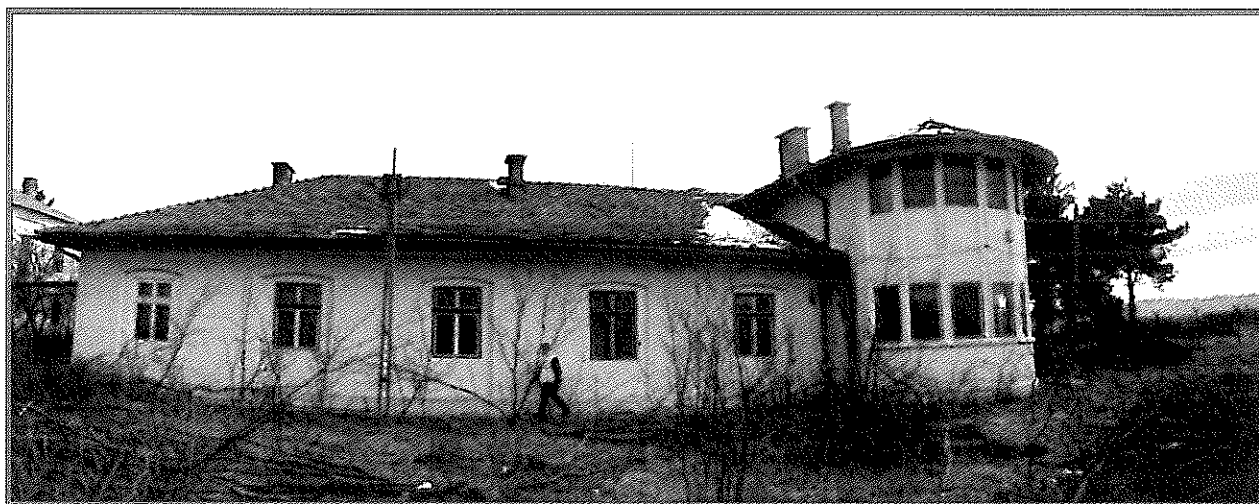
PAVILION L (C4) – ADMINISTRATIV, VEDERE DINSPRE VEST ARIPA NORDICĂ (P) ȘI ZONA COMANDĂ (P+E) DIN ARIPA SUDICĂ
