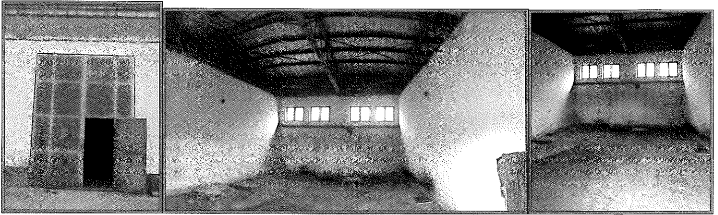
PAVILION G – GARAJE (C3) CU 7 GARAJE ȘI MAGAZIE:UȘĂ ȘI INTERIOARE GARAJ (3)
