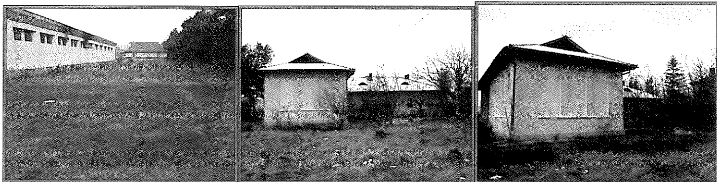
VEDERE DINSPRE SUD: DETALIU PLATFORMĂ ASFALT, ȘI RESPECTIV PAVILION L (C4) – ADMINISTRATIV - COMANDĂ: VEDERI DINSPRE EST
