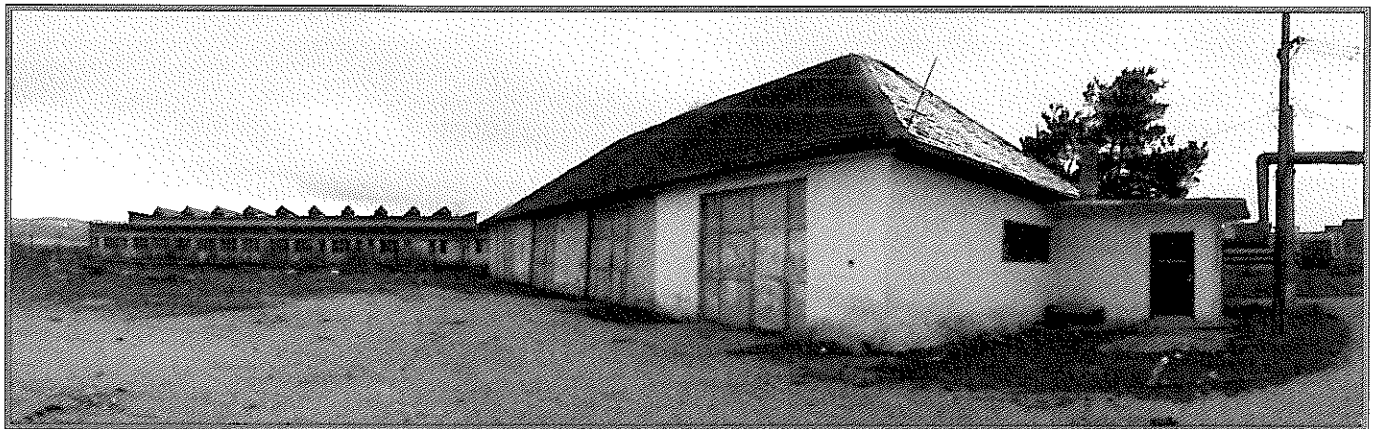
VEDERE PAVILION O - REMIZĂ (C1) CU 4 GARAJE ȘI CU CABINĂ PORTAR, DINSPRE SUD-EST
